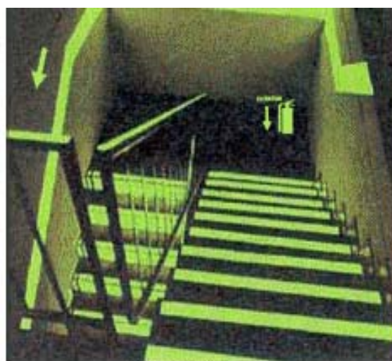
Escaleras en la que se han aplicado productos fotoluminiscentes. Vistas bajo luz natural y en la oscuridad.
