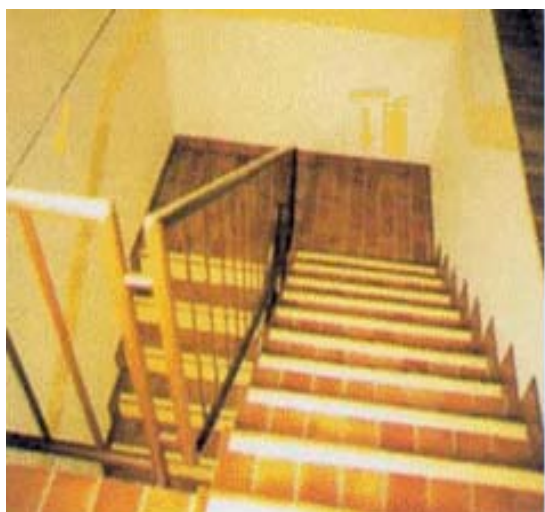
Escaleras en la que se han aplicado productos fotoluminiscentes. Vistas bajo luz natural y en la oscuridad.
